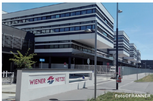
Trittschalldämmung mit Regupol® Sound 17 für Wiener Netze, Smart Campus
