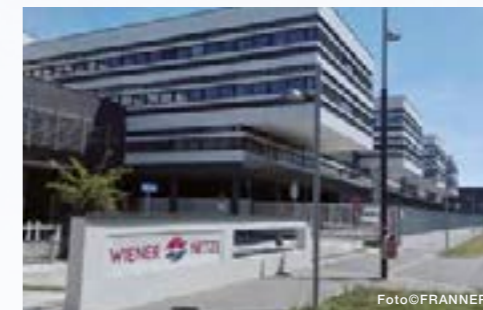
Trittschalldämmung mit Regupol® Sound 17 für Wiener Netze, Smart Campus
